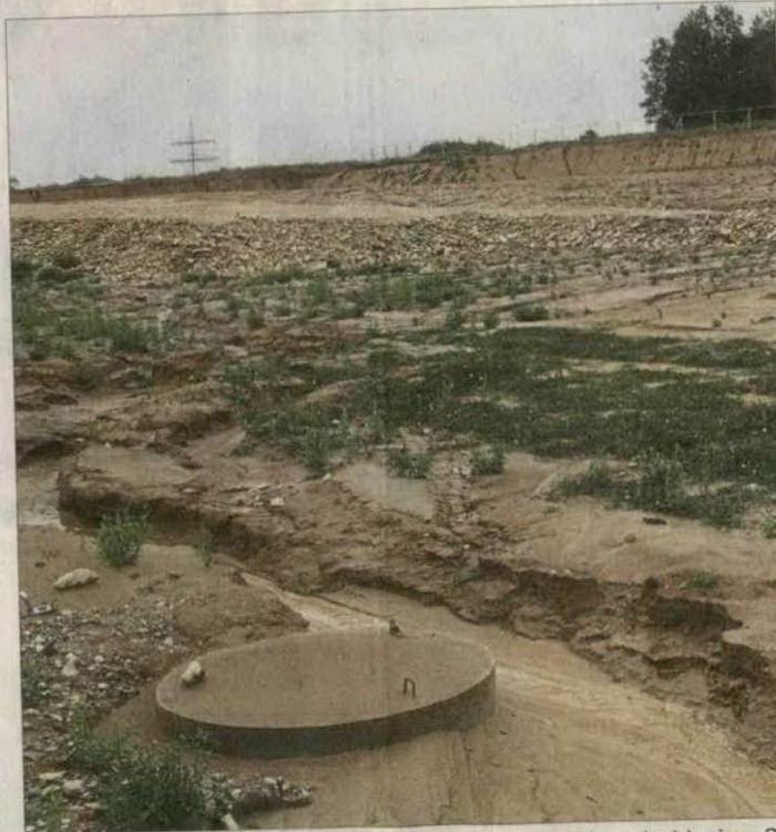
Schulstandort in spe: Auf dem Gelände wird schon bald eine 35 Millionen Euro teure Schule entstehen.
